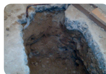
Réalisation de l'excavation sous dalle
