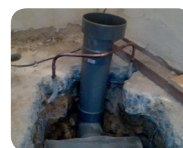
Mise en place du puisard
